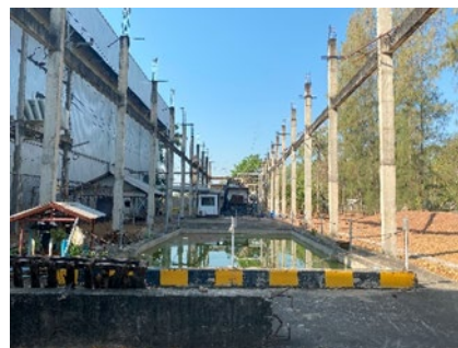
14 อาคาร BOILER 1
