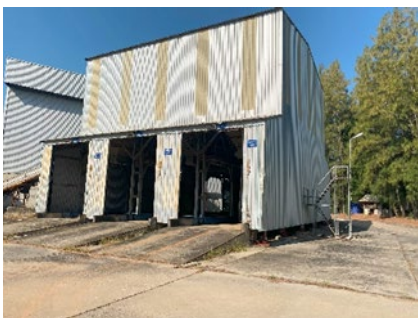
13 อาคารปล่อยสินค้า
