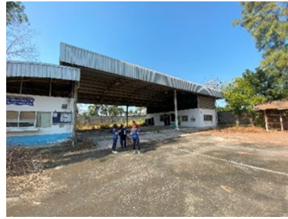
2 อาคารซ่อมบำรุง
